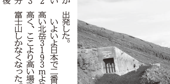
下山道にある落石防止シェルター 整備のために登山協力は義務化に
