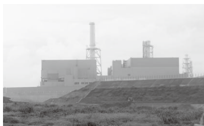
敷地外から浜岡原発5号機を仰ぎみる
