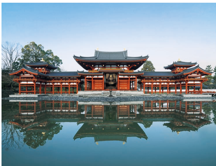
平成修理後の平等院鳳凰堂(平等院提供)
