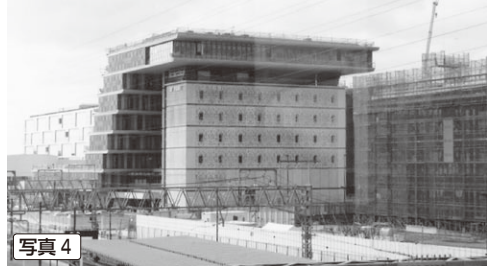
写真1: 今年10月開業予定の、建設中のイオンモール、写真2: 道路を挟んだ向かいにある巨大な駐車場の建設、写真3: 渋滞が予測される、イオンモール前の東海道線路下の地下道、写真4: 完成間近の京都銀行研修センター
